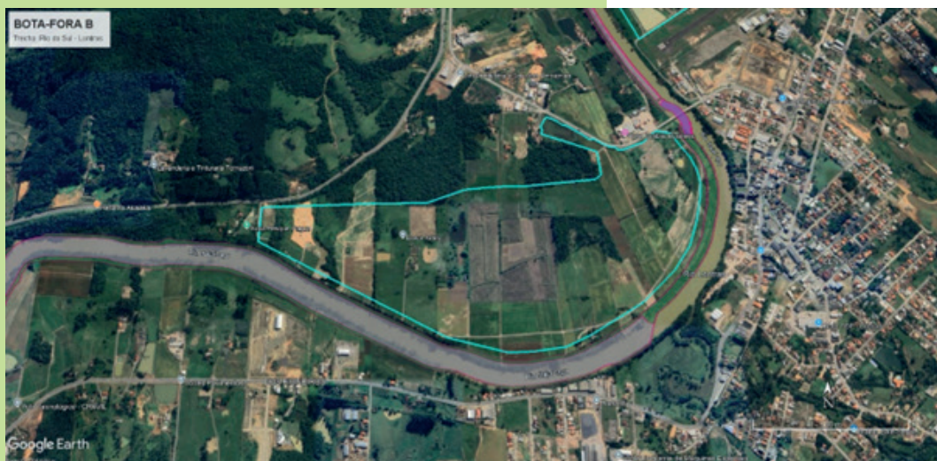
Bota-fora B - Trecho Rio do Sul - Lontras (Google, 2024)
