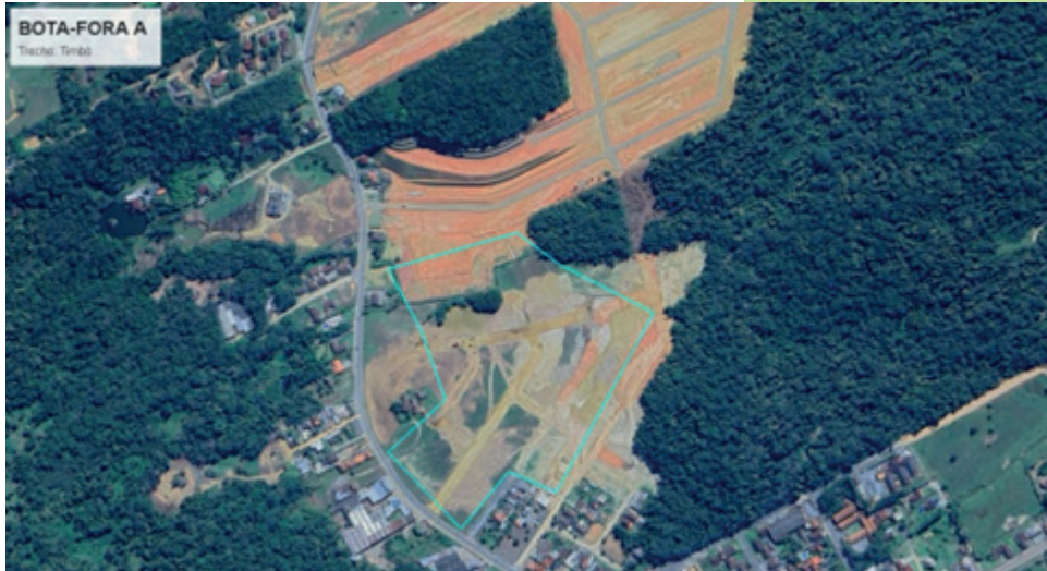
Bota-fora A - Trecho Timbó (Google, 2024)
