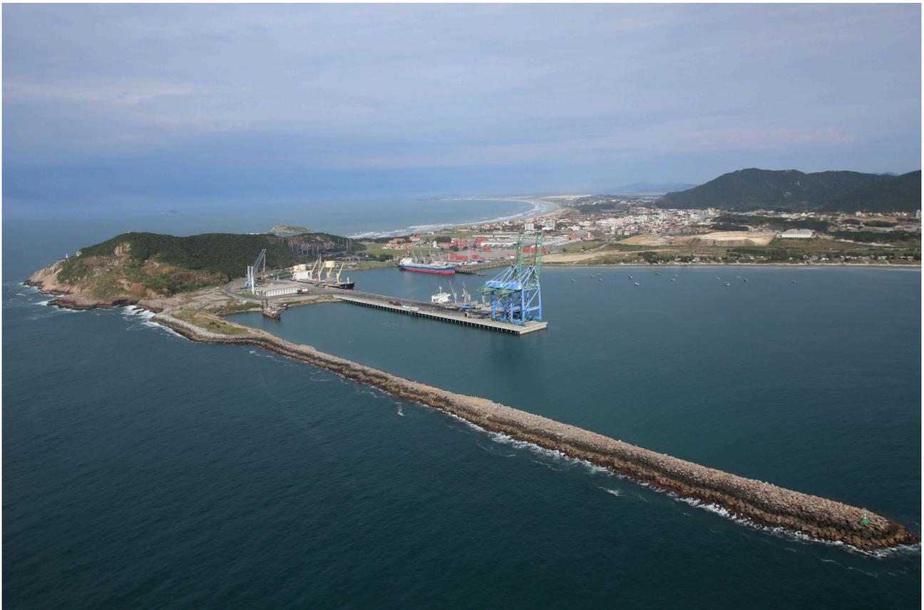
**Figura 15.** Imagem aérea do Porto de Imbituba - destaque para a infraestrutura de molhes para proteção costeira. Fonte: SCPar Porto de Imbituba.
